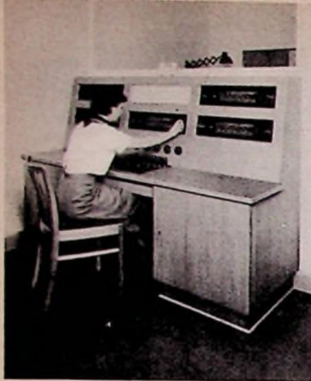
Bild 1. Zentralgesteuerte Rundfunkübertragungsanlage mit fünf Rundfunkempfängern und Zehnplattenspielern
